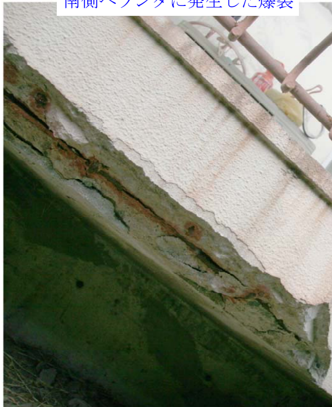
南側ベランダに発生した爆裂
