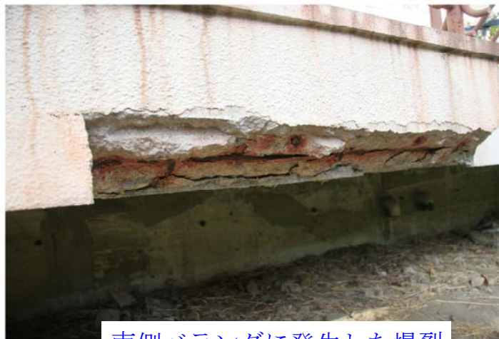
南側ベランダに発生した爆裂
